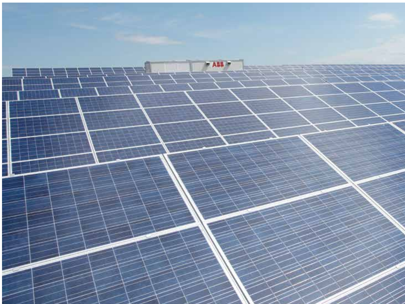
Photovoltaik-Kraftwerk mit 50 MWp in Pobeda, Bulgarien: ein gutes Beispiel für das Vertrauen in ABB Solar-Wechselrichter
