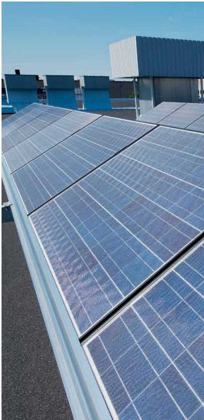
Das PV-Kraftwerk von ABB Helsinki: Hier werden wichtige Forschungs- und Entwicklungsprojekte sowie Tests durchgeführt.
