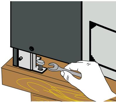
Dopo aver rimosso le pareti laterali dell'imballo è necessario scollegare l'inverter dal bancale in legno sottostante, al quale è fissato tramite appositi bulloni (agli angoli dell'apparecchiatura) utilizzando la chiave inglese fornita a corredo.
