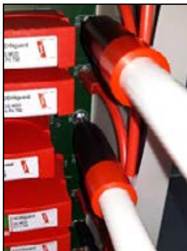
Exemple : Test entre CH9(-) et PE
